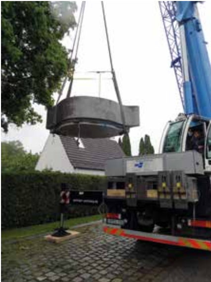
Es klappt, und schon geht es mit Hilfe des großen Autokrans „in die Lüfte“ - über die Hecke hinweg zur Aussegnungshalle.
