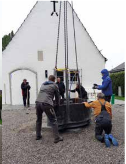
bevor der Brunnen an Ort und Stelle abgesetzt und ausgerichtet werden kann.
