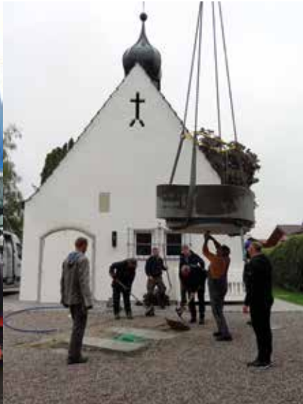
Dort sind noch finale Arbeiten für den Leitungsanschluss des Brunnens erforderlich,
