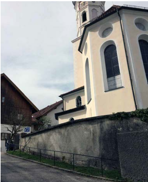
Das neue Geländer.
